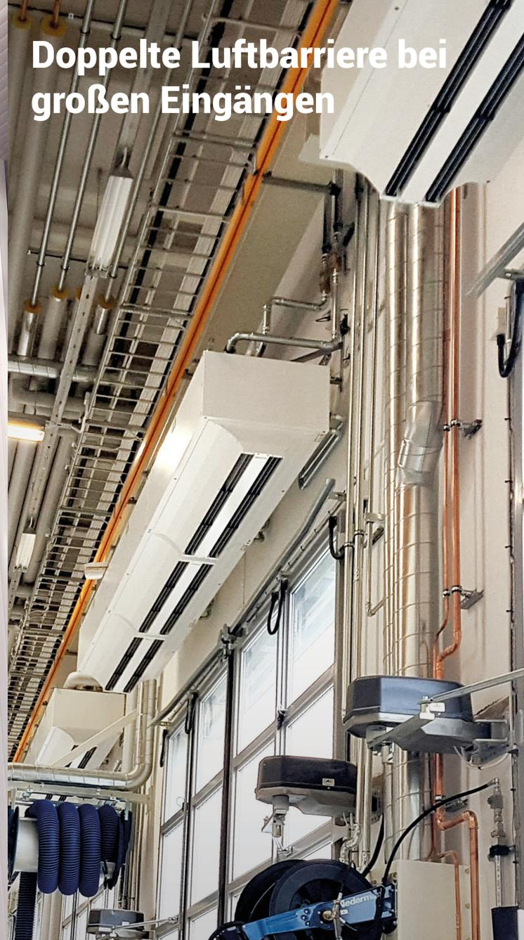
MAXWELL Hochleistungs-Luftscheier für hängende oder beidseitig stehende Montage an Industrieeingängen. Doppelter Luftstrom und Coanda-Effekt für mehr Effektivität zum Einsatz bei großen Dimensionen. Die Module können leicht zusammen montiert werden, und eine längere oder breitere Abschottung erzielen.
