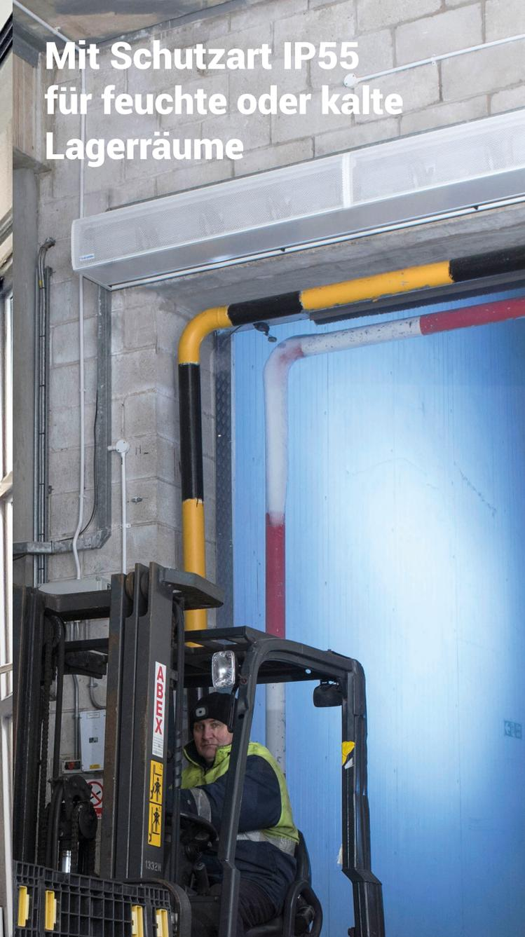
KOOL erzeugt eine Luftbarriere mit hoher Geschwindigkeit und wenig Turbulenzen und macht eine effektive Klimatrennung, auch an Kühlagern. Die Schutzart IP55 ist eine geeignete Produkteigenschaft in feuchter, kalter und korrosiver Umgebung.
