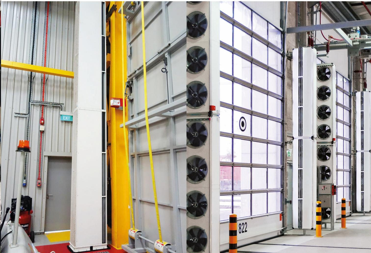
Windbox BB, L und XL Luftschleier-Geräte erzeugen zur Klimatreue eine effektive Hochdruck-Luftbarriere an Eingängen bis 8m Höhe, und reduzieren die Wärmeverluste bei offenen Toren. Die Montage kann hängend, beidseitig stehend oder in einer Zwischendecke eingebaut sein.
